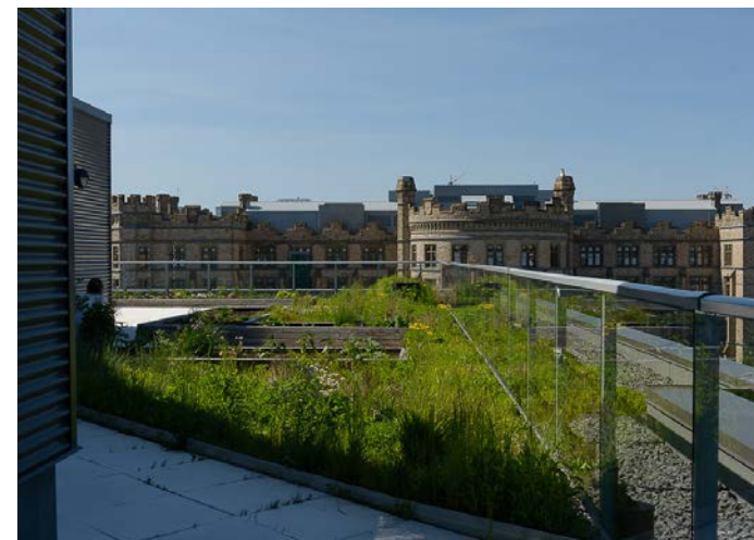
Beaver Barracks Community Housing Green Roof/ Toit vert des logements communautaires Beaver Barracks
